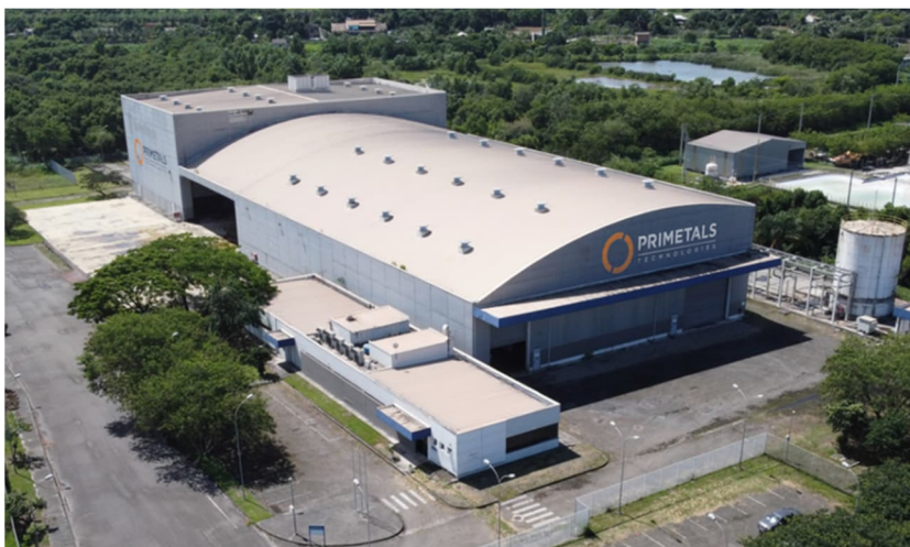
Die neue Werkstatt von Primetals Technologies in Santa Cruz, Brasilien.
