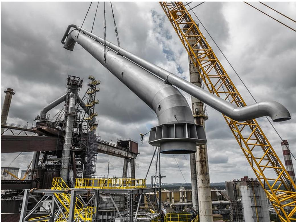
Монтаж установки газоочистки от Primetals Technologies: 1000-тонный кран поднимает на нужную позицию окончательный элемент нисходящей трубы.
