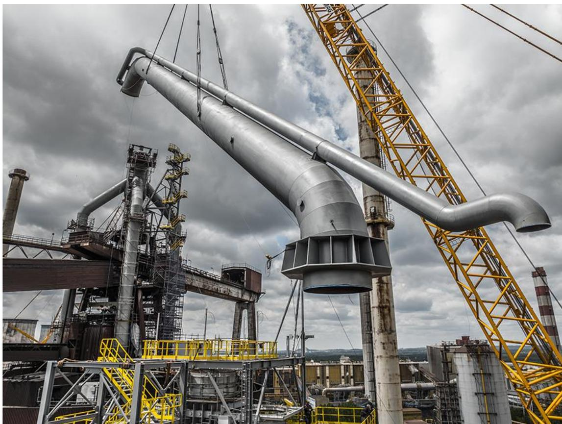
プライメタルズ テクノロジーズ製排ガス処理プラントの建設で、1000 トンクレーンがダウンカマリーの最終ピースを所定の位置まで運ぶ
