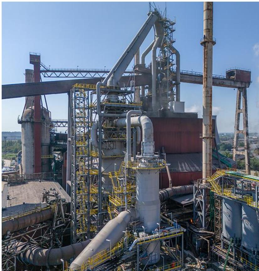
アルセロール ミittal ドンブロヴァー グルニチャ工場の No. 2 高炉に新設されたプライメタルズ テクノロジーズ製排ガス処理プラント
