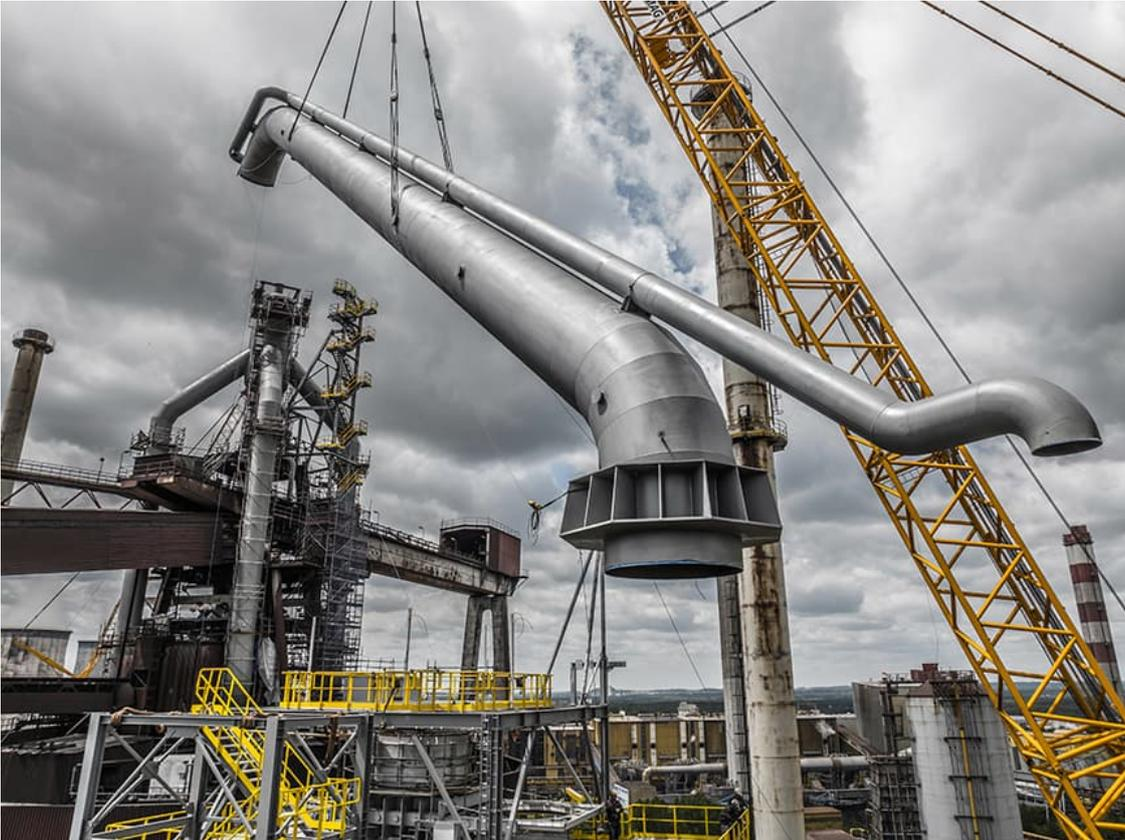
普锐特冶金技术气体净化系统的建设——一台 1,000 吨起重机将下降管末段吊装到位。
