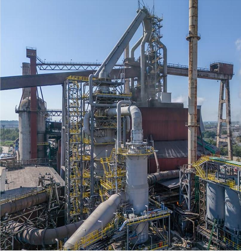
阿赛洛米塔尔 Dąbrowa Górnicza 厂的 2 号高炉和普锐特冶金技术提供的新气体净化系统。
