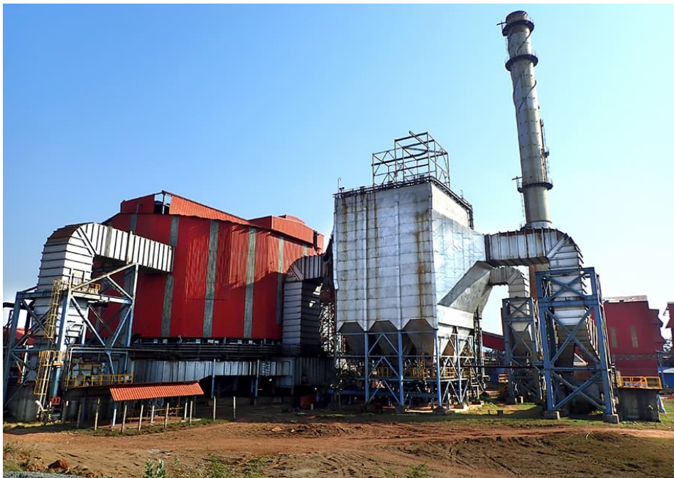
Planta de pelotização circular da Primetals Technologies na usina da EMIL na Índia.
