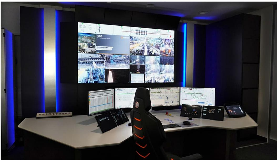
Das Central Operation Cockpit (COC) von Primetals Technologies ist ein bahnbrechendes Konzept, das es einem einzigen Bediener ermöglicht, eine gesamte Anlage zu steuern.
