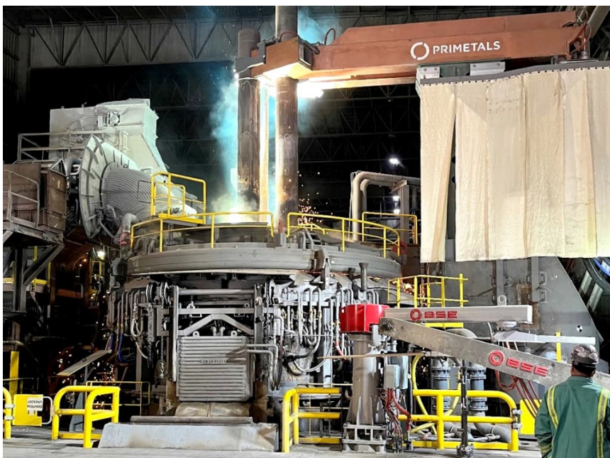
由普锐特冶金技术进行改造的 118 吨电弧炉正在冶炼第一炉。
