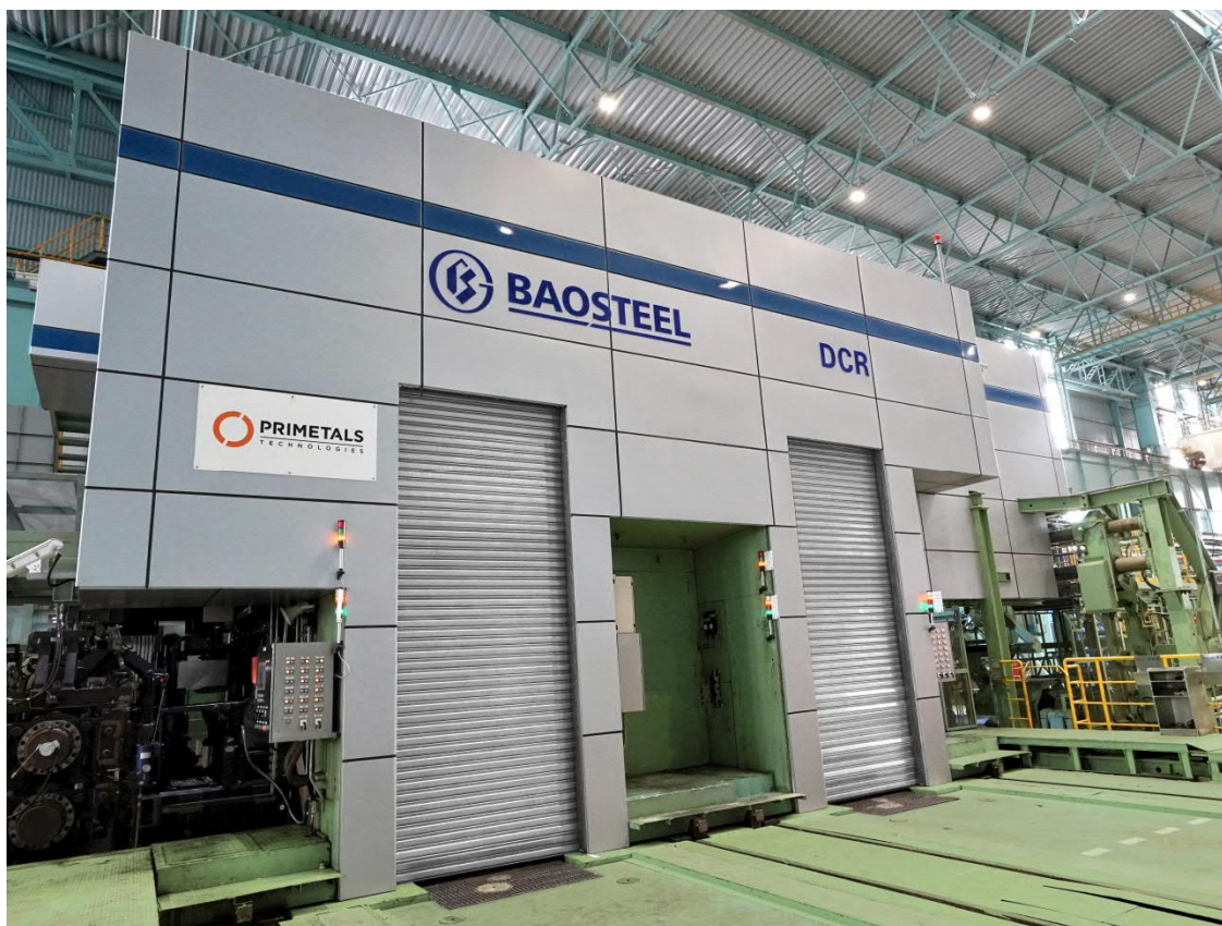
Vista frontal do novo laminador DCR da Baosteel, fornecido pela Primetals Technologies
