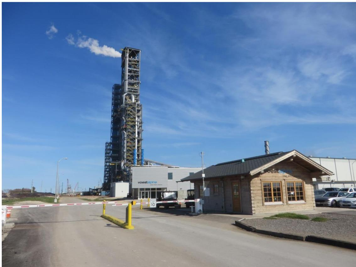
Die Midrex-Direktreduktionsanlage von voestalpine nahe der Stadt Corpus Christi in Texas am Golf von Mexiko. Das größte Einzelmodul dieser Art weltweit wurde von Primetals Technologies und Midrex Technologies, Inc. gebaut und erreichte im Februar 2017 die Parameter der Leistungsgarantieprüfung (Foto mit freundlicher Genehmigung von voestalpine).
