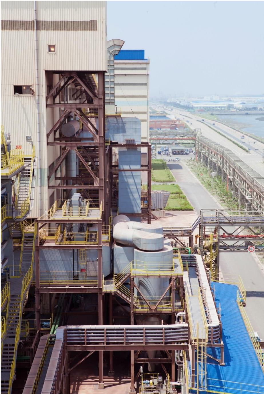
Selektive Abgasrückführungsanlage (selective waste gas recirculation; SWGR) von Primetals Technologies
