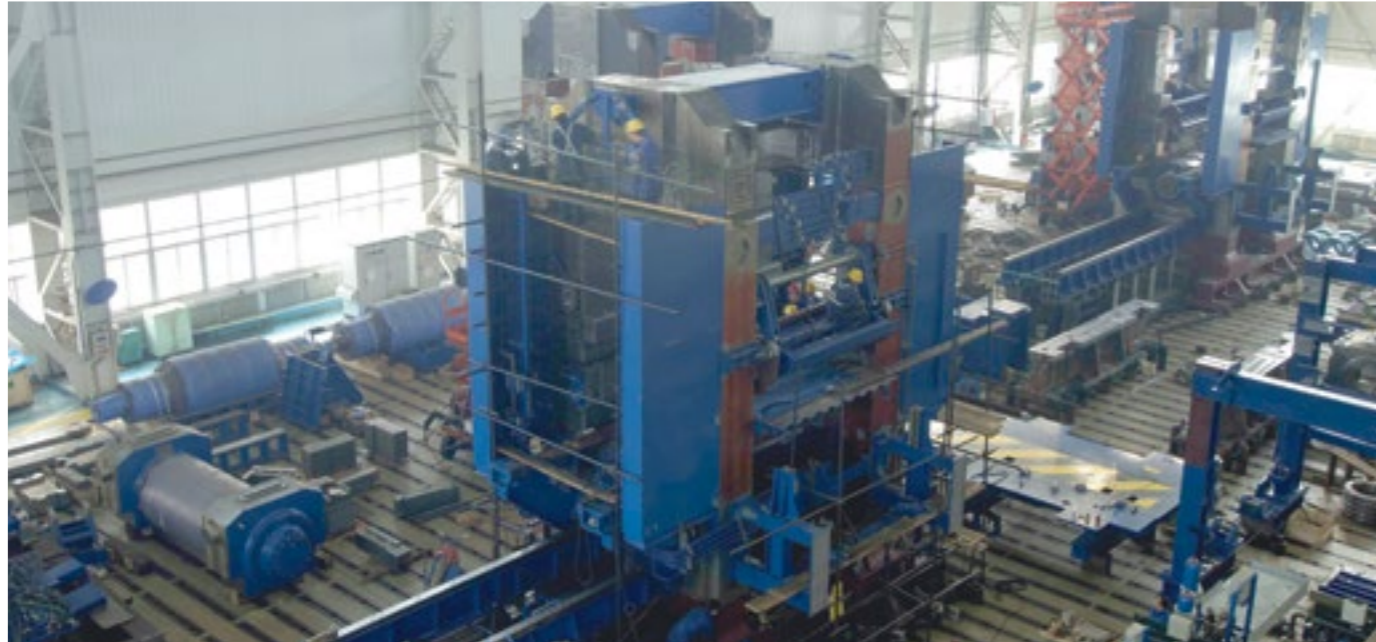
Chinalco Ruimin - mill build
